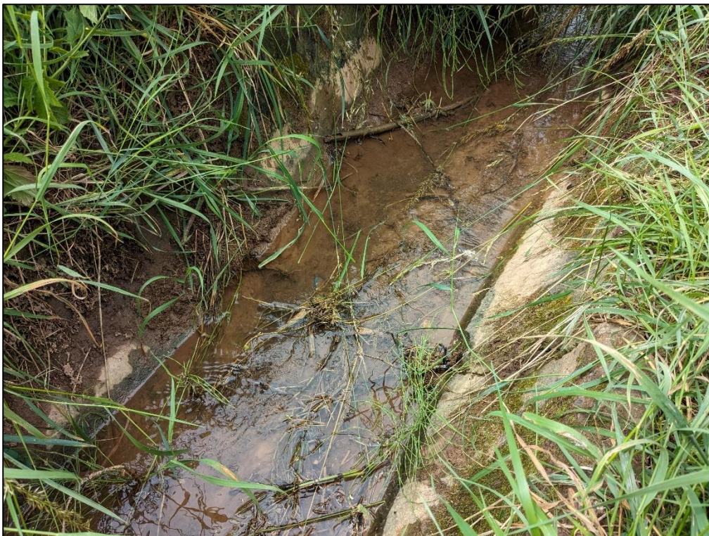
Abbildung 9 Als Betonrinne ausgebautes Bachbett des Sachsgrabens
