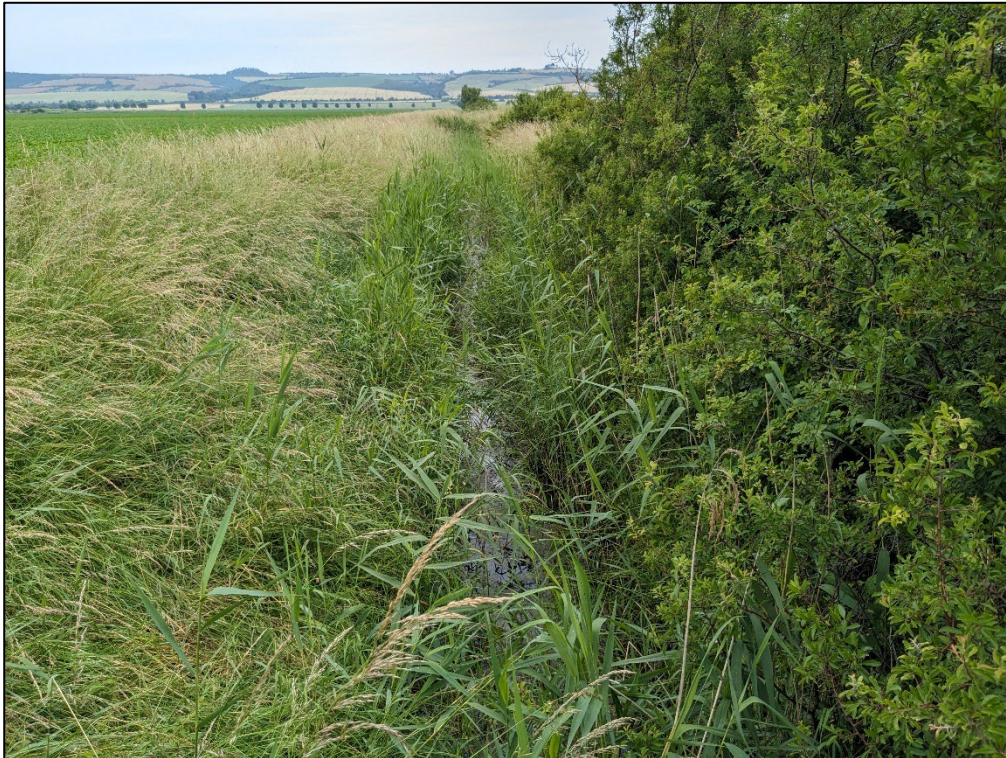
Abbildung 10 Meliorationsgraben am Südrand des Geltungsbereichs
