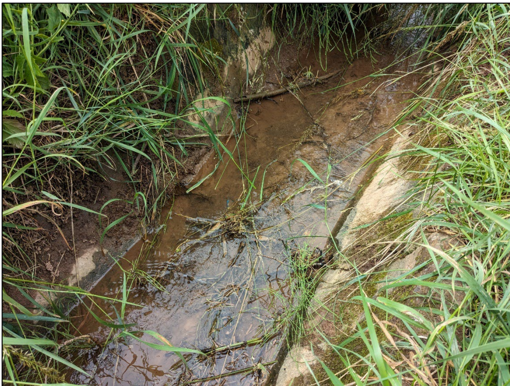
Abbildung 9 Als Betonrinne ausgebautes Bachbett des Sachsgrabens
